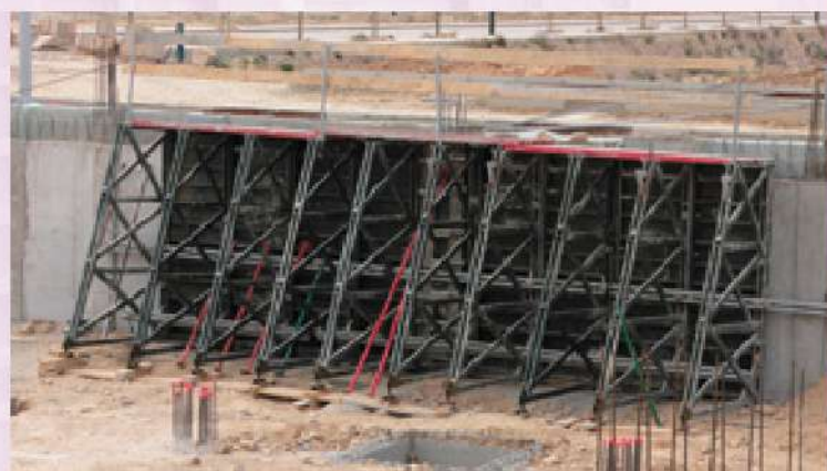
Muro a una cara y 3 metros de altura utilizando la parte inferior de la vela de 6 metros.
