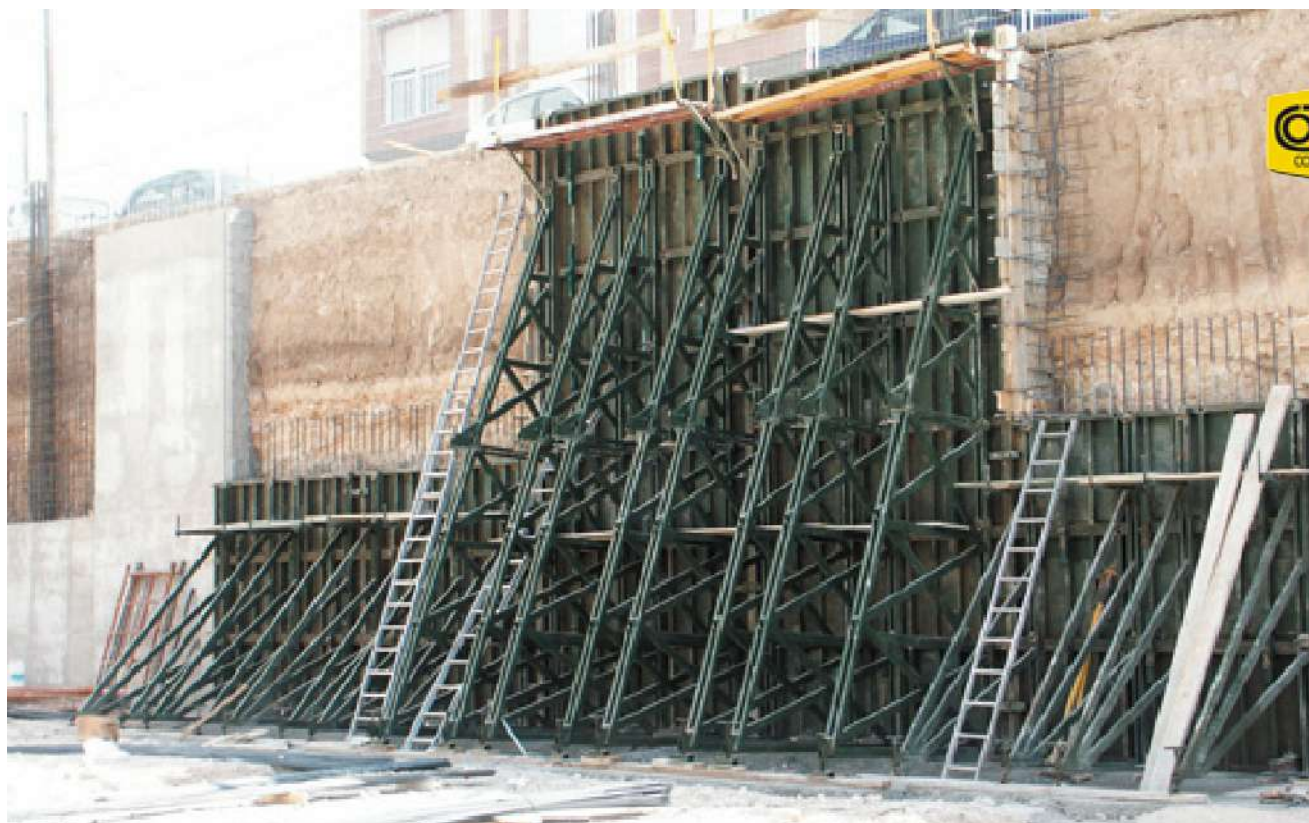
Muro a una cara con velas de 3 y 6 metros.
